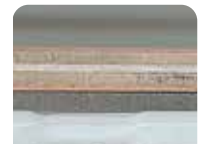
2.5mm クッションフロア 12mmコンパネ 5mm断熱材 車両床
