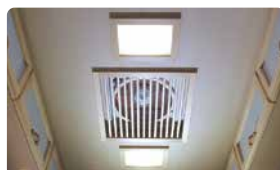
LED室内灯(2箇所)/ LEDダウンライト(6箇所) リヤスピーカ/マックスファン(格子付)
