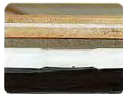
天井下地にフェルト15mmを 張っています。パネルに5mm ウレタン付生地を張っています。
