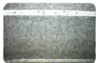
天井下地にフェルト15mmを 張っています。パネルに5mm ウレタン付生地を張っています。
